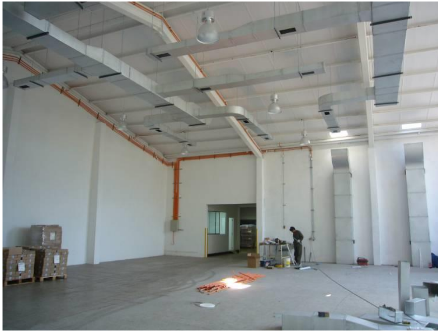
Construcción Bodega Climatizada Imprensa Salesianos
